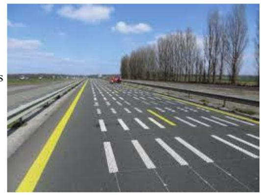
QUELQUES SIGNAUX DE LA SIGNALISATION HORIZONTALE La ligne de rive simple ou ligne de type T2 : elle comprend des traits pleins et des intervalles ; située à droite elle sépare la chaussée à l'accotement. La longueur du trait plein est de 3m et l'intervalle 3,5m
